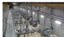
ポンプ設備更新工事
