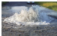
水道管が腐食して 漏水した道路
