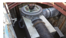
構内水管耐震化工事 (不断水切替弁)
